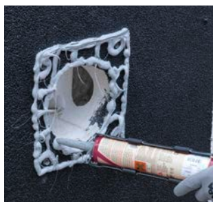
surface préparée avec EGO MS-805
