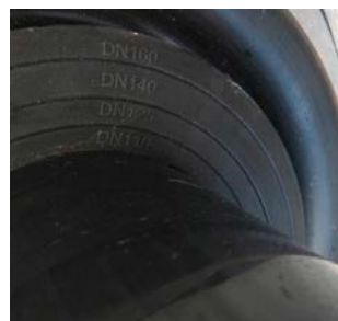
manchette d'étanchéité com- pensatrice devant le mur ADM – bagues segmentées
