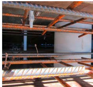
ZVR 200/300 fixé en coffrage
