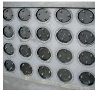
FZR 100/240 étanchéification canalisation
