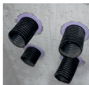
vue de l'intérieur du bâtiment (anneau de centrage)
