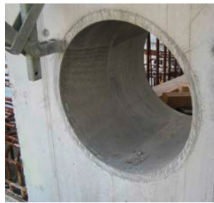
FZR 400/300 site de montage station d'épuration
