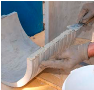
FZR-G 350/300 application de l'enduit compris dans le kit d'assemblage Z-FZR-G
