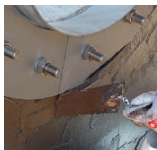
HRD 300-FUF/300 version acier inoxydable liée au revêtement bitumineux épais plastique modifié à l'aide d'une garniture d'étanchéité, voir page 37
