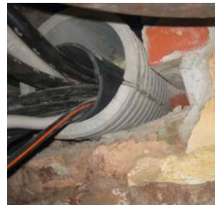
FZR-G 150/350 travaux de rénovation
